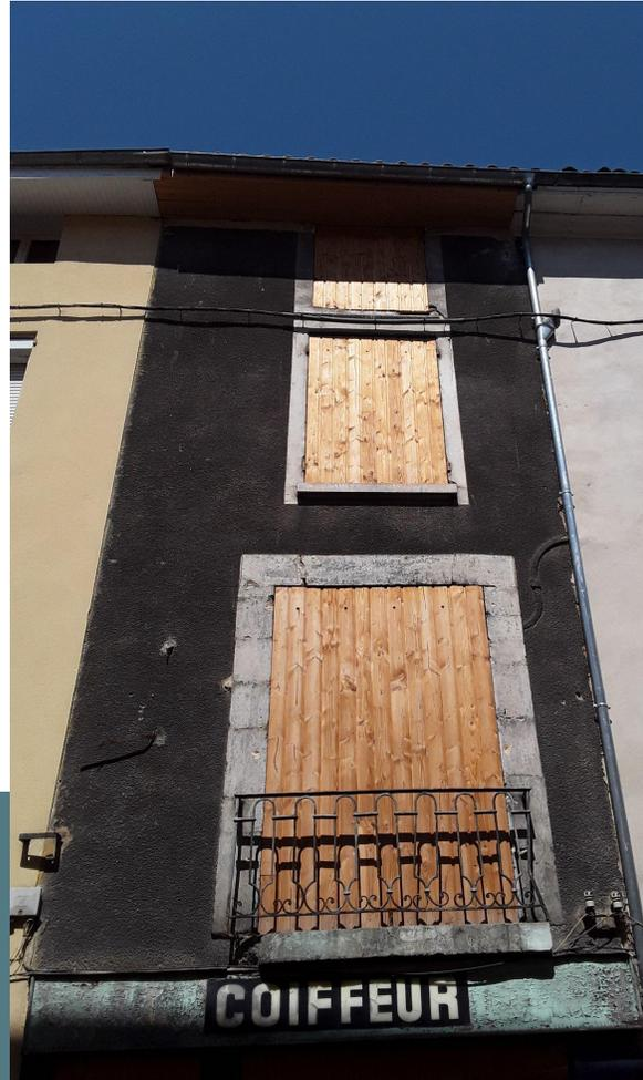
*Enduits noircis ou fissurés, remontées telluriques, enduits peu adaptés à la pierre ou au pisé, volets dégradés, peinture qui s'écaille, ...*
