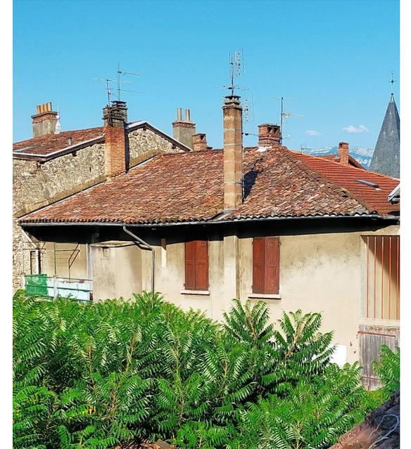
*Couverture poreuse, infiltrations visibles en parties communes, maçonnerie de souche de cheminées dégradées, ...*
