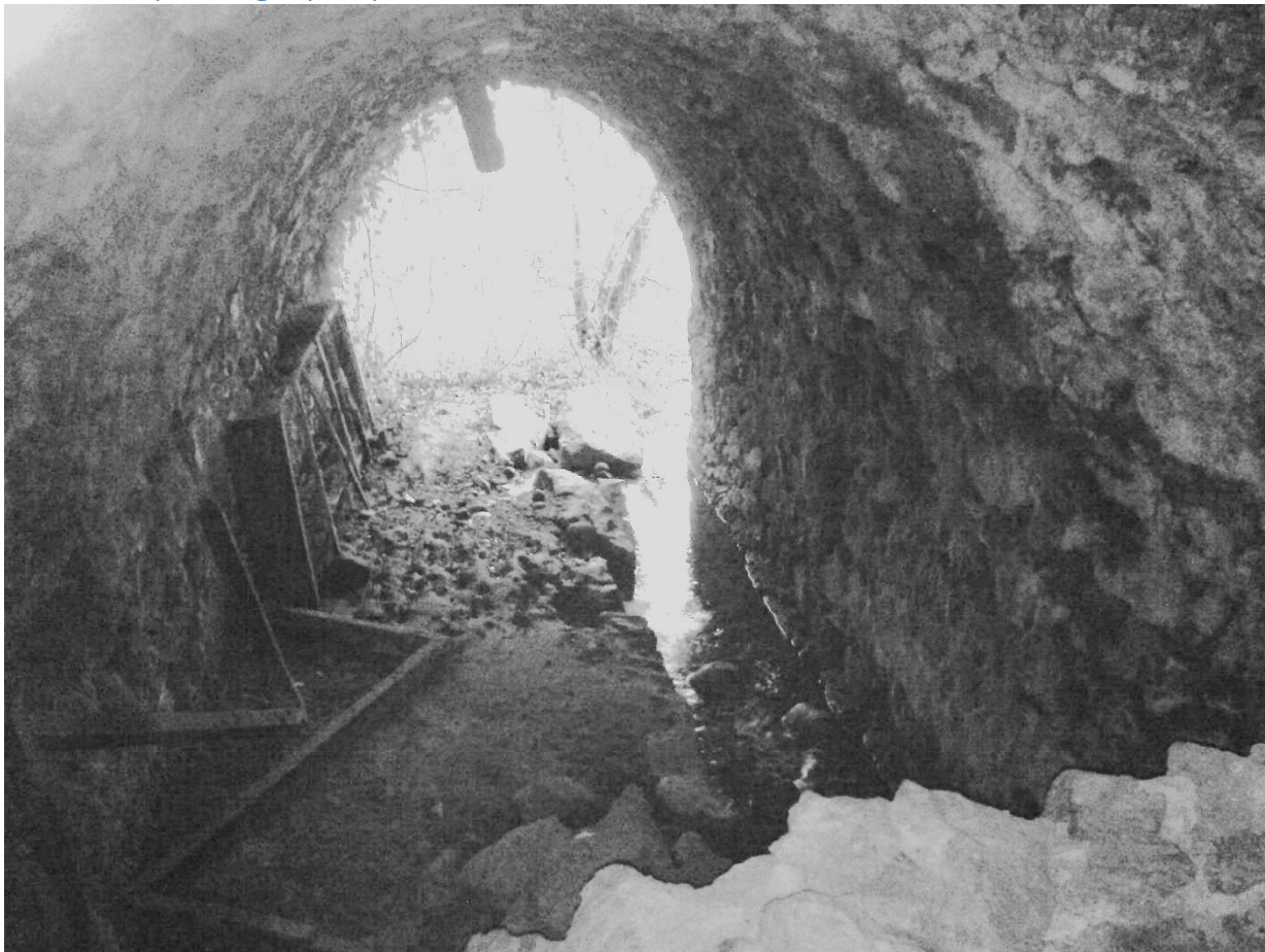
PHOTO 1 : SORTIE DU DALOT DEPUIS LE MUR
